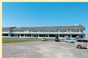
震災遺構請戸小学校 外観
