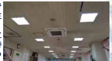
照明のリニューアル で、より快適なデイ ケア室に。
