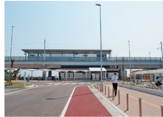
被災後新しく開通した新坂元駅
